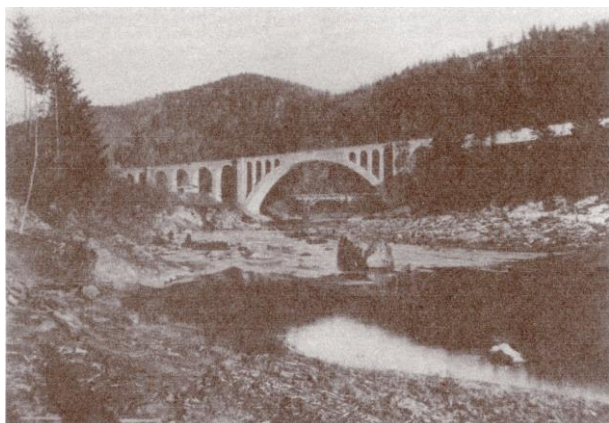
65 metrowy główny łuk mostu w Jaremcu na Prucie, trasa do Woronienki
