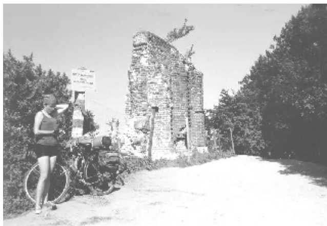
Ostatnia ściana kościoła w Trzęsaczu fot. Leszek Cytawa
