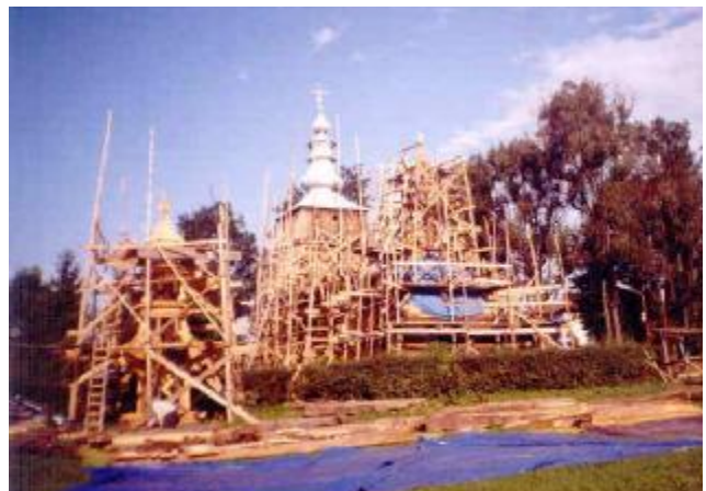
Remontowana cerkiew p.w. Kosmy i Damiana w Krempnej
